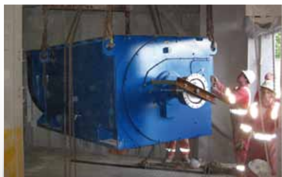
Schleifringläufermotor EMZ ASL630-6 bei der Montage 3.500 kW, 11.000 V, 992 rpm
