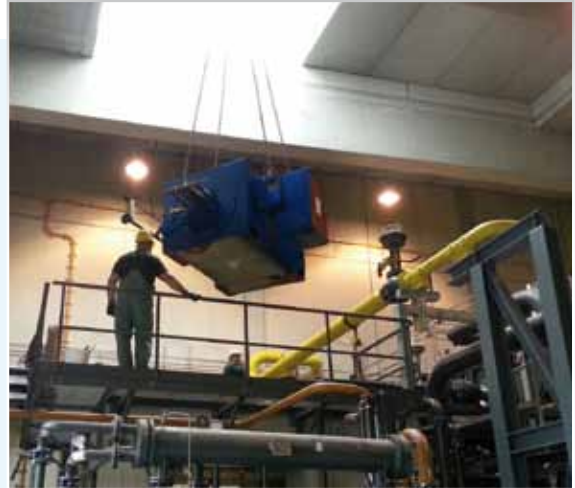
Montage und Inbetriebnahme AKD 630-06, 5.300 KW, 6.600 V, 1.490 rpm
