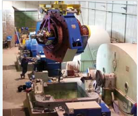
Montage 1.700 kW SL Motor nach Stator & Rotorneuwicklung
