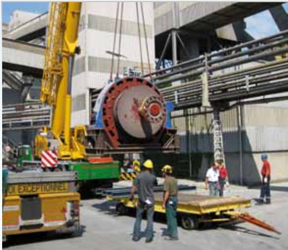
Demontage 1.700 kW Kugelmühlenantrieb
