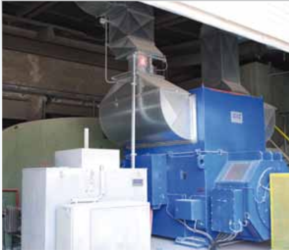
Flüssigkeitsanlasser DFA 2000 für Kugelmühle ASD 710-12, 2000 kW, 10.000 V, 495 rpm
